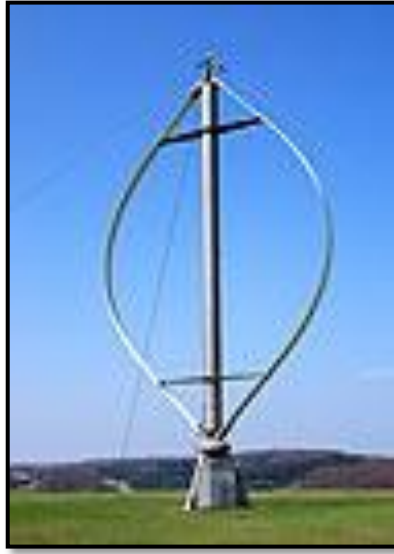
شكل (٣) توربين رياح محور رأسي
